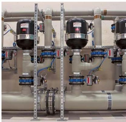
Impianto di filtrazione dell'acqua per il trattamento dell'acqua costituito da tubi e raccordi SIMONA® PP-H AlphaPlus®.
