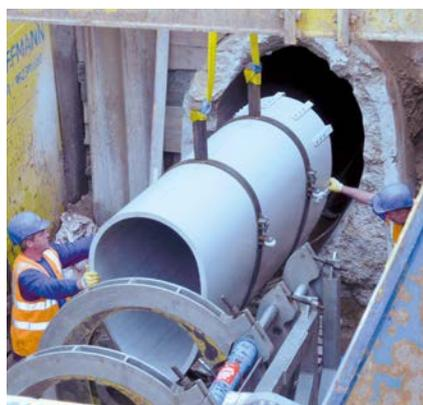
Risanamento di un canale di fognatura con profili a sezione ovoidale grigio chiaro SIMONA® PE 100
