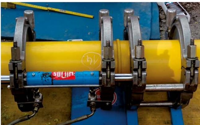
Saldatura di una condotta del gas SIMONA® PA 12
