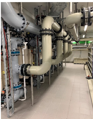
Links oben: Be- und Entlüftungsleitung Neutralisationsbehälter Links unten: Schlammwasserleitung Ultrafiltrationseinheit Rechts: Umwälzleitung Neutralisationsbehälter
