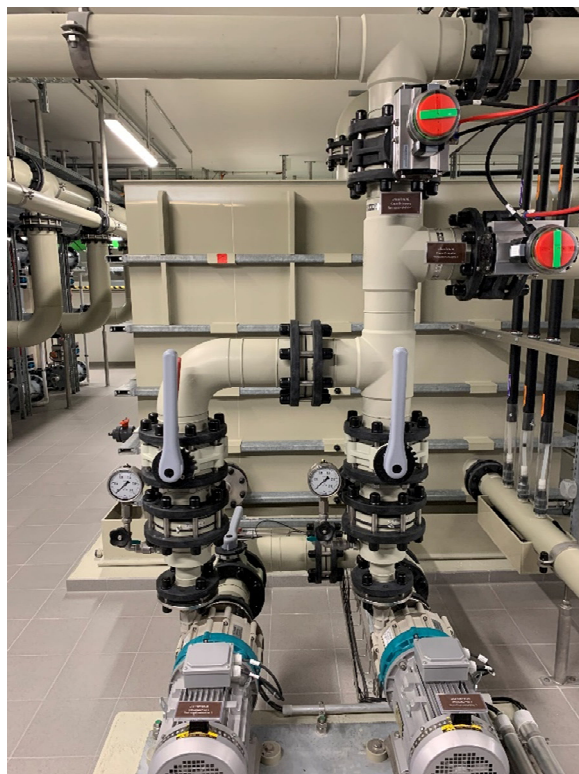
Links oben: Be- und Entlüftungsleitung Neutralisationsbehälter Links unten: Schlammwasserleitung Ultrafiltrationseinheit Rechts: Umwälzleitung Neutralisationsbehälter
