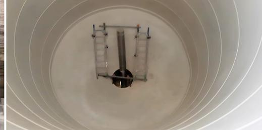
v. l. n. r.: Fixierung der grauen SIMONA® PP-H AlphaPlus® Platten im Inneren des Silos; Zwischenraum zwischen den Ankernoppen und der Betonwand; Blick in das Silo nach Fertigstellung der Auskleidung
