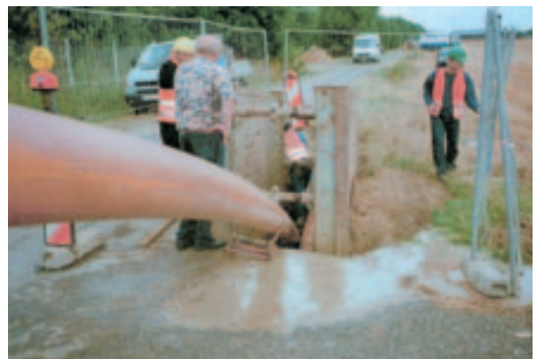
Einzug der Rohre über eine Startgrube in die Halterung
