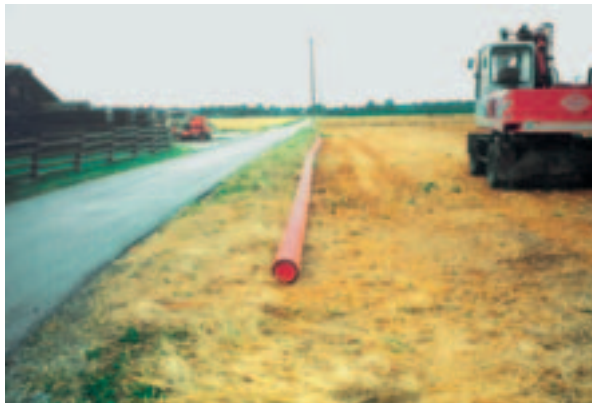
Vorverschweißter Rohrstrang zum Einbringen in die Halterung
