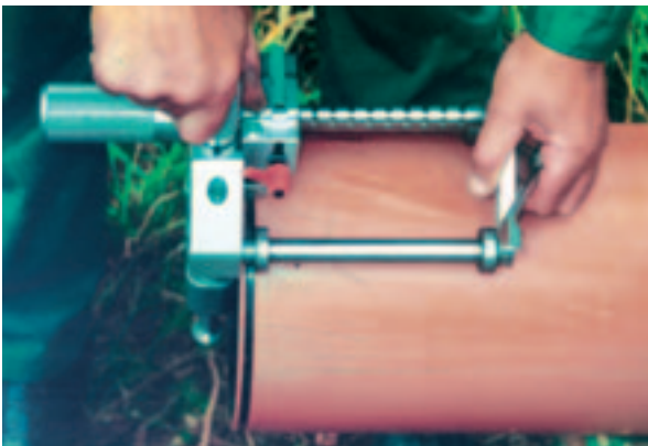
Vorbereitung der Rohrstirflächen für Heizelementstumpfschweißen (HS). Der Schutzmantel wird nur im Bereich der Schweißzone entfernt.
