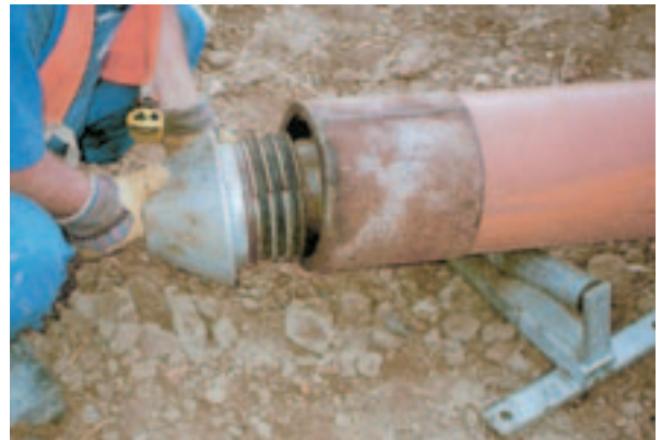
Anbringen des Zugkopfes am SIMONA® SPC-Schutzmantelrohr
