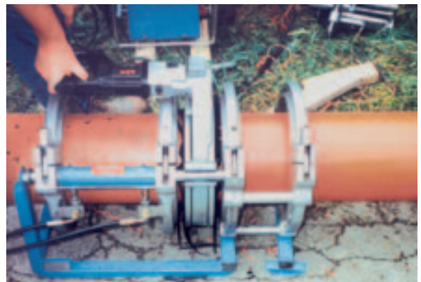
Vorbereiten der Rohre für die Heizelementstumpfschweißung durch Planhobeln der Stirnflächen
