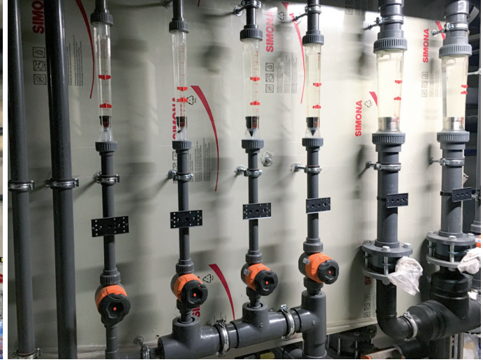
Links: SIMONA® PE 100 Rohrleitungen, PE 100 T-Stücke mit reduziertem Abgang und PE 100 V-Bunde wurden für die Badwasseraufbereitungsanlage eingesetzt. Rechts: Die Captura® Filteranlagen von aquila wurden aus SIMONA® PP-H AlphaPlus® Platten gefertigt.
