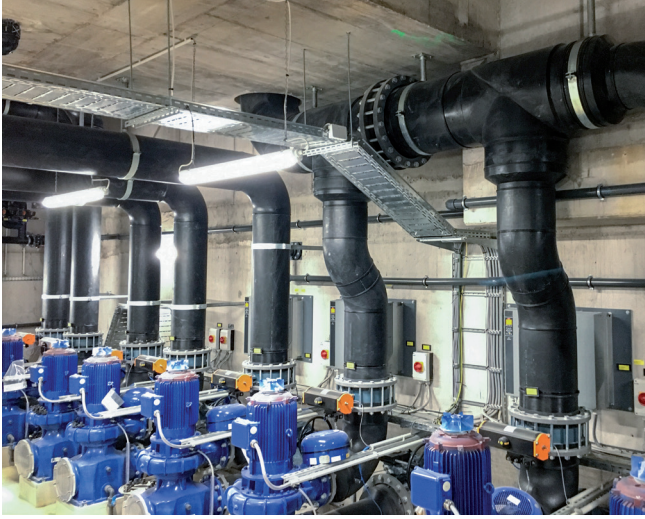
Links: SIMONA® PE 100 Rohrleitungen, PE 100 T-Stücke mit reduziertem Abgang und PE 100 V-Bunde wurden für die Badwasseraufbereitungsanlage eingesetzt. Rechts: Die Captura® Filteranlagen von aquila wurden aus SIMONA® PP-H AlphaPlus® Platten gefertigt.
