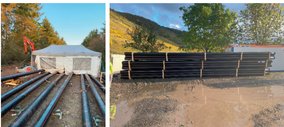
Oben: Einbau der Rohre mittels Horizontalspülbohrverfahren (nach HDD). Unten links: Parallelverschweißung im Heizelementstumpfschweißverfahren mehrerer Kabelschutzrohrstränge im Zelt. Unten rechts: gelieferte SIMONA® PE 100 Kabelschutzrohre an den Moselhängen bei Bullay.
