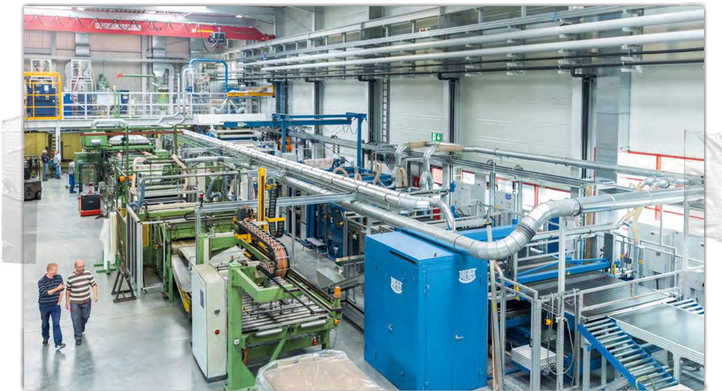
Das neue Technologiezentrum in Kirn
